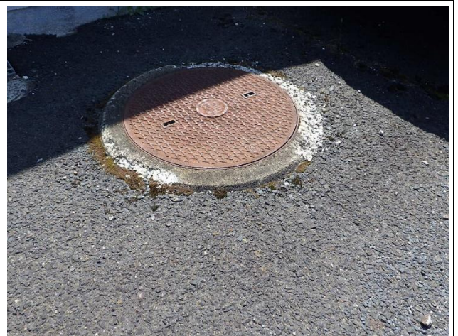
④ 舗装面を補修する際は、各種マンホール蓋 （2箇所）の周囲と段差を微調整
