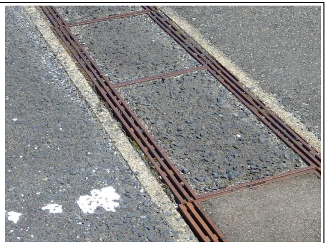
② 現側溝（鉄製・内部にアスファルト合材） 破棄し内部を清掃、新グレーチングに交換
