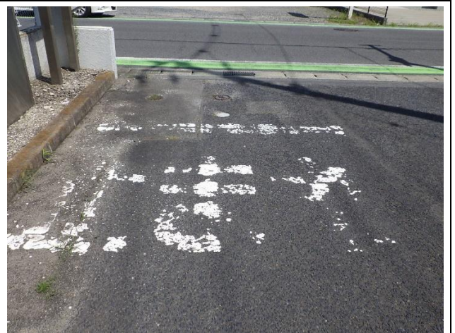
⑥ 公道出口に「止まれ」表示する箇所
