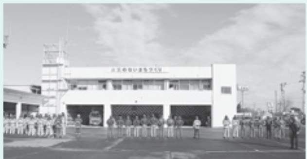
解体予定の旧消防本部・黒川消防署庁舎
