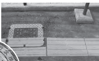
例 地下式消火栓 [場所により異なります]
