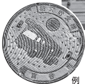
例 地下式消火栓 [場所により異なります]
