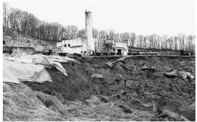
H23. 3 東日本大震災被災状況（環境衛生センター法面崩落）
