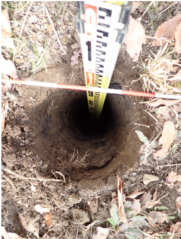
試掘完了 L=1.00m
