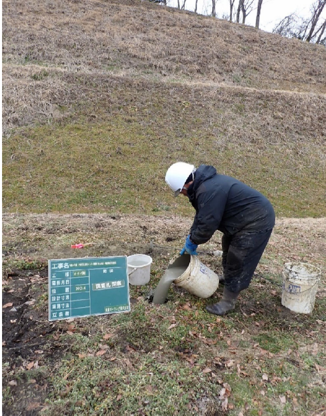
調査孔閉塞状況
