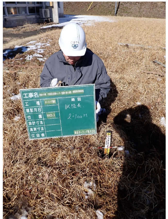
試掘完了 L=1.00m
