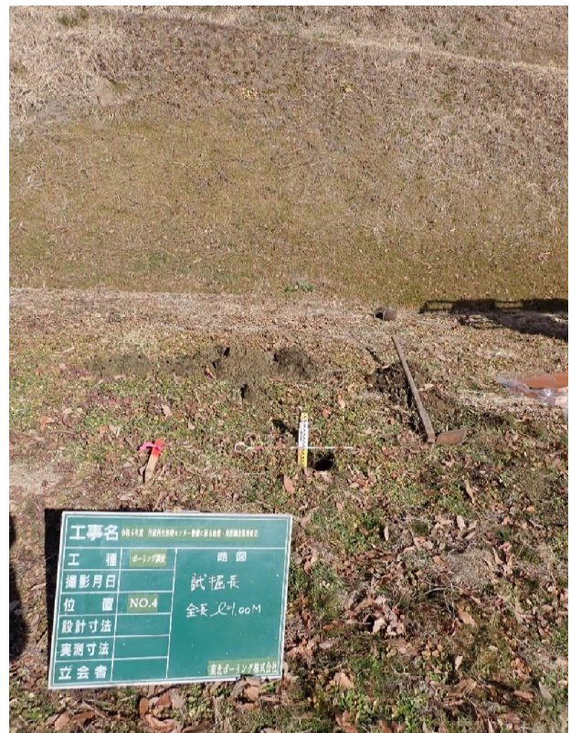
試掘完了 L=1.00m
