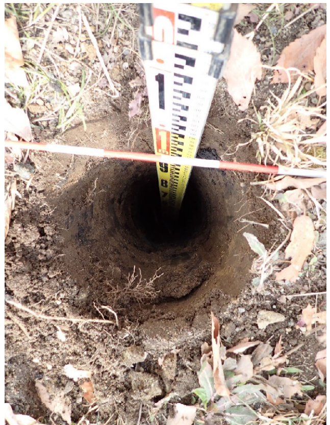
試掘完了 L=1.00m
