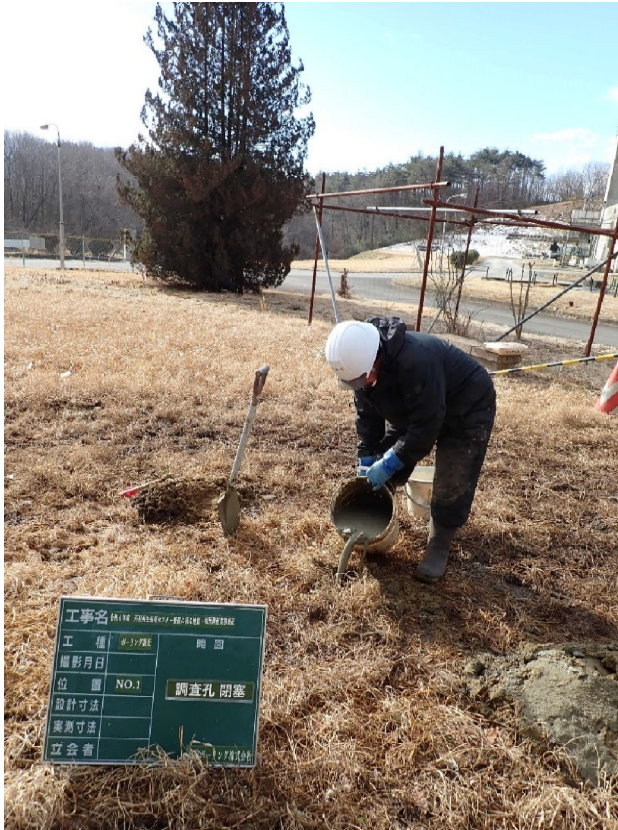
調査孔閉塞状況
