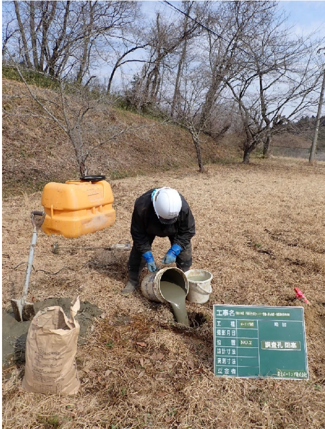
調査孔閉塞状況
