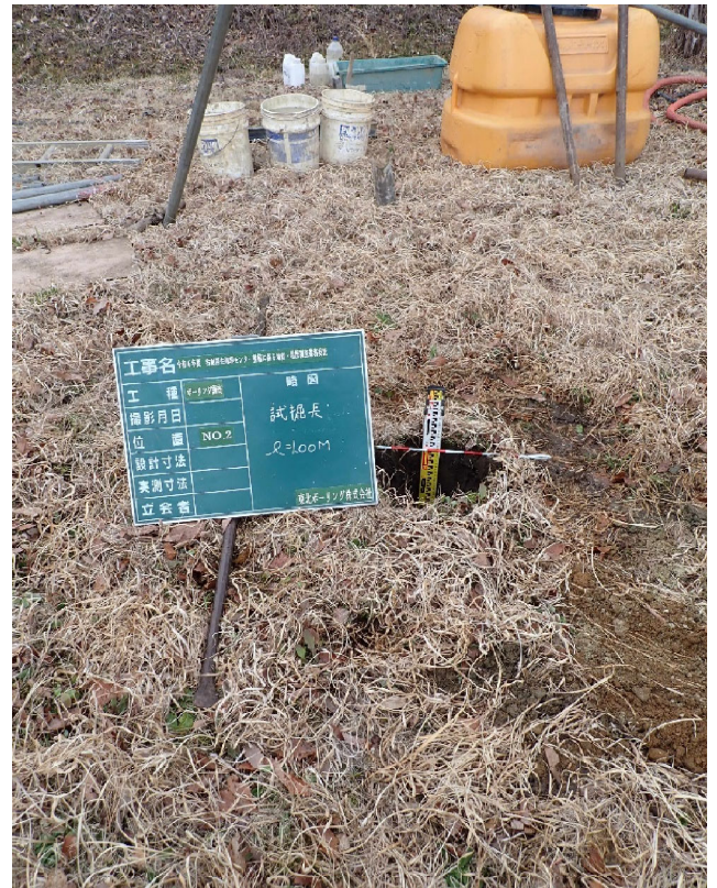
試掘完了 L=1.00m
