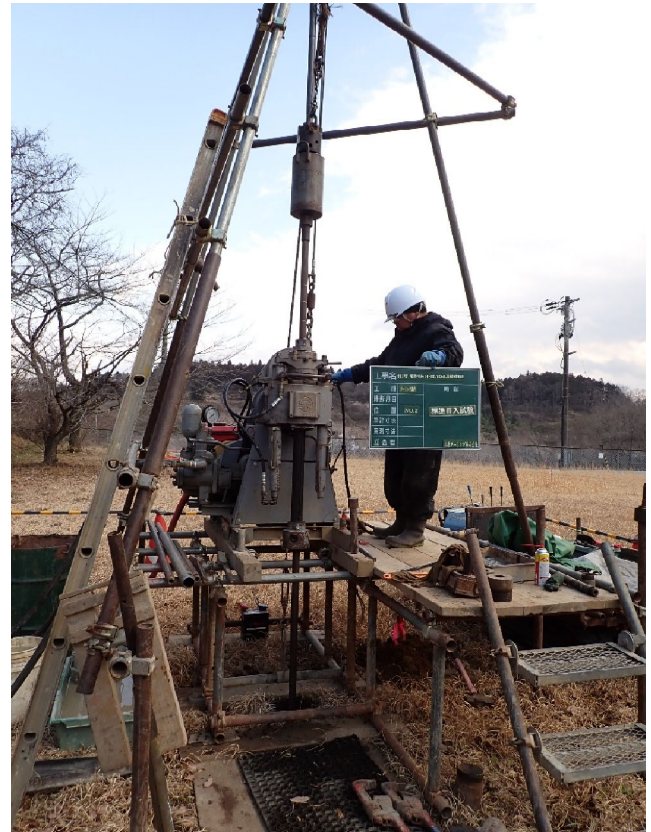
標準貫入試験状況
