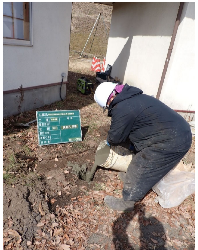
調査孔閉塞状況
