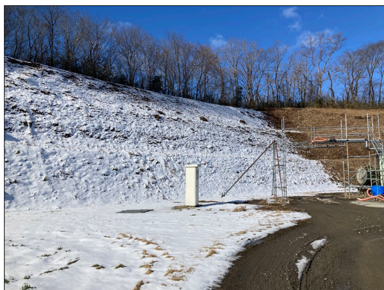
写真 2-3 調査地西側の切土斜面(2025/2/21 撮影)
