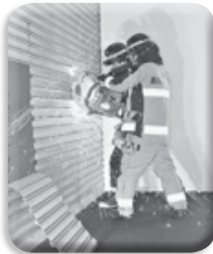
シャッター破壊の様子
